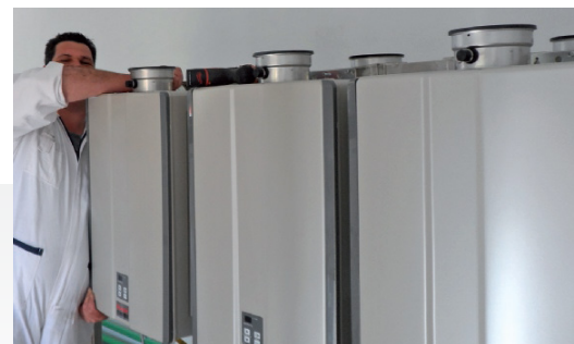
L'INSTALLATORE durante la fase di posa dei moduli Modus Infinity
